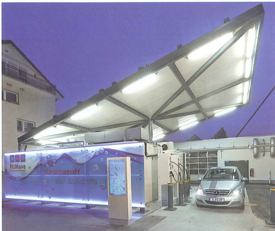
▲ En Allemagne, l'institut de recherche Fraunhofer ISE a conçu une station-service à hydrogène. Un électrolyseur fonctionnant grâce à des panneaux photovoltaïques permet de produire directement l'énergie nécessaire.
