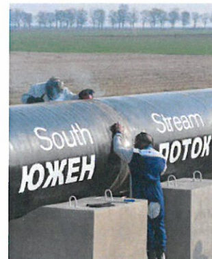
Cérémonie de jonction d'un tronçon du gazoduc South Stream en Bulgarie à l'automne 2013. © Gazprom.com
